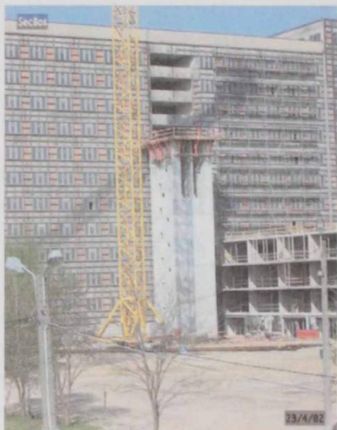
Część budynku Wieloprofilowego Szpitala Klinicznego.
