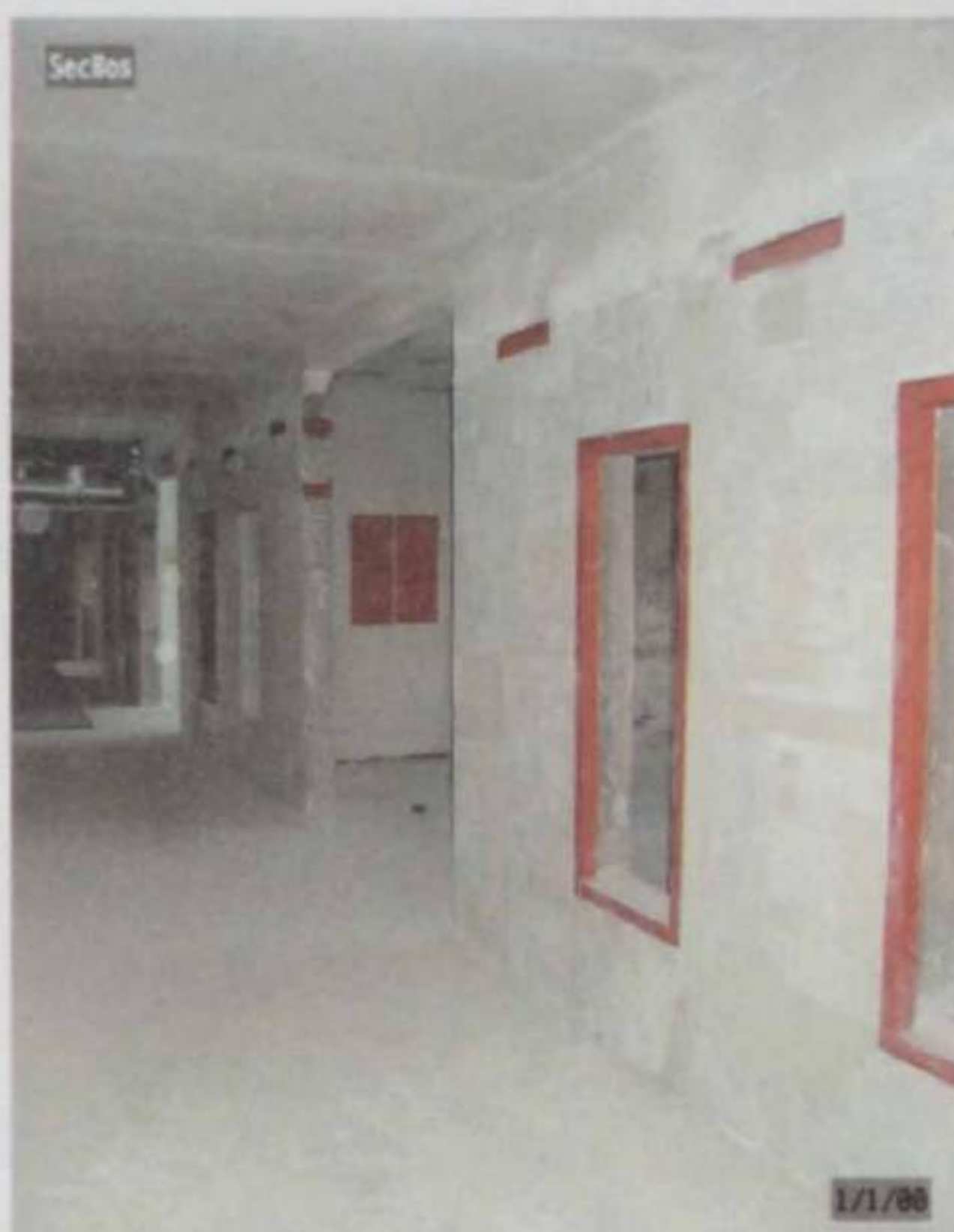
Korytarz w stanie surowym....
