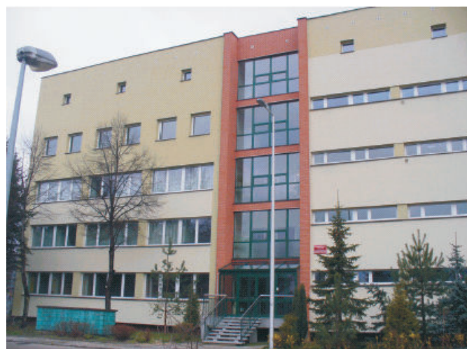
Centrum Medycyny Doświadczalnej po termomodernizacji i wykonaniu nowej elewacji budynków.
