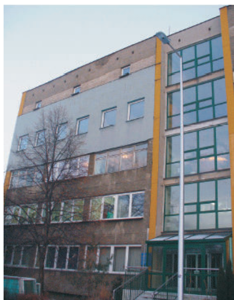
Centrum Medycyny Doświadczalnej w Katowicach-Ligocie przed remontem elewacji.
