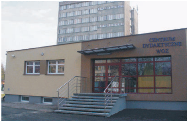
Centrum Dydaktyczne Wydziału Opieki Zdrowotnej, utworzone w budynku byłej stołówki w Katowicach-Ligocie.
