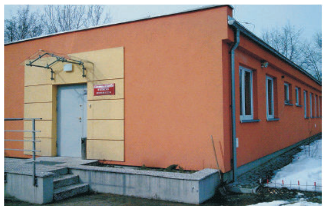
Archiwum SUM w wyremontowanym budynku socjalnym byłego Zarządu Inwestycji w Katowicach-Ligocie.
